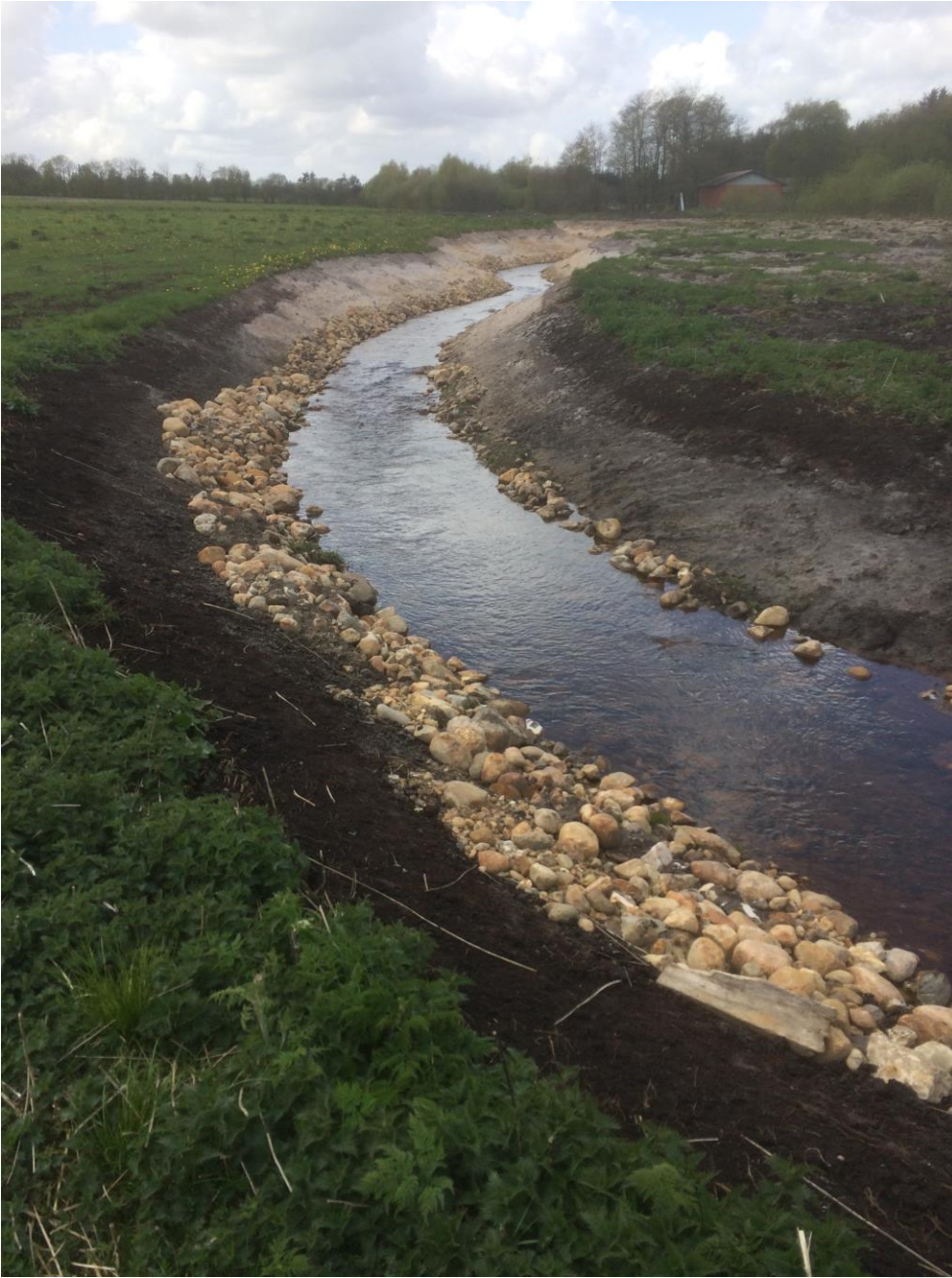
Ny faunapassage ved Egebæk Dambrug
